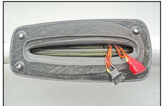
Рис.7 – Проведенные провода для крыла
