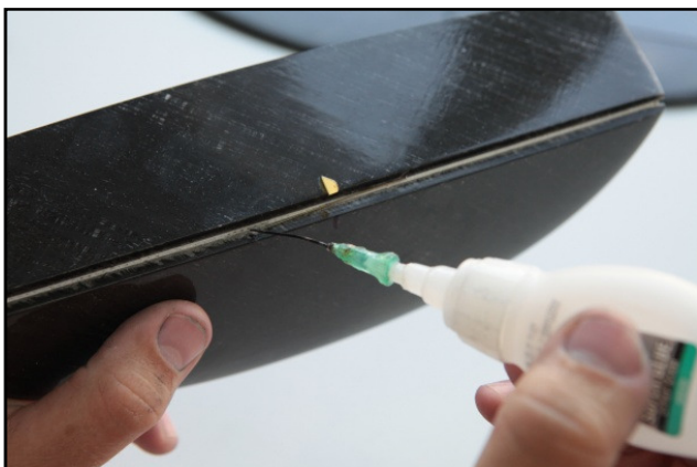
Рис.2.6 – Проклейка торсионов оперения
